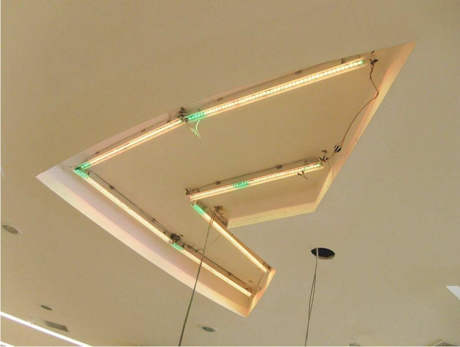
OVSL 8 Bölge Adreslenebilir Yarı Açık RGB Tüplerle Yapılmış Akış Etkili Tavan Havuzu
