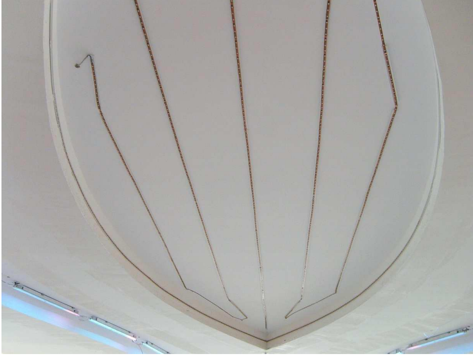
OVHL RGB SMD LED Şeritle Döşeli Tavan Havuzu -Kontrol Odasından Merkezi Kumandalı-
