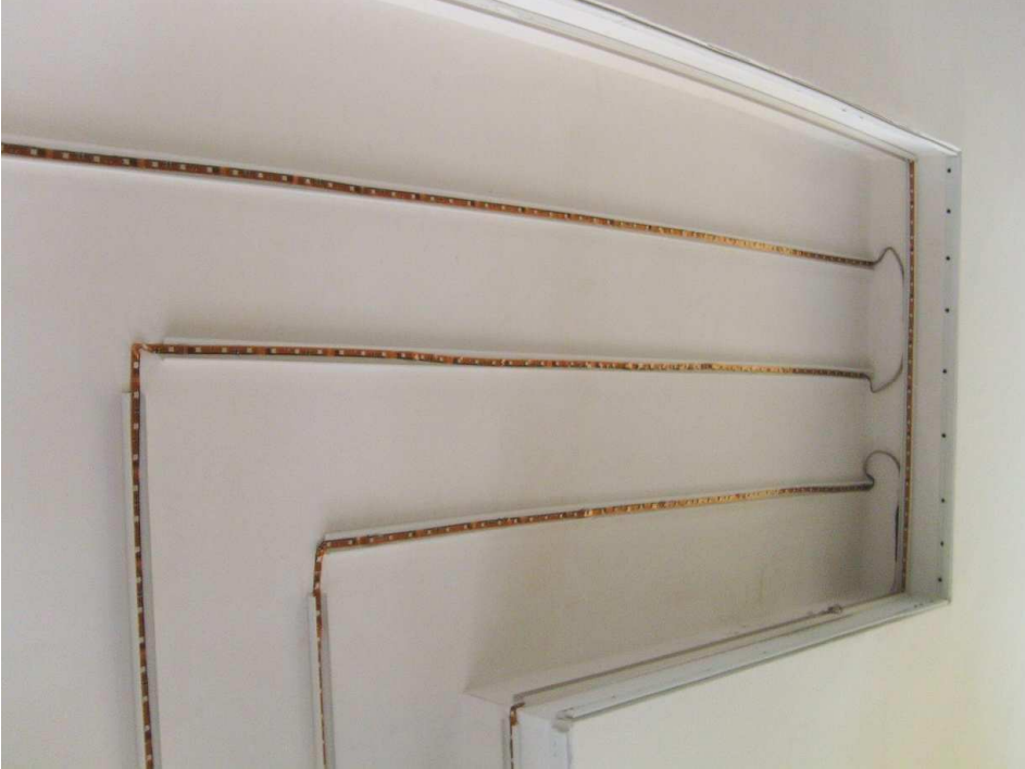
OVHL RGB SMD LED Şeritle Döşeli Tavan Havuzları, Montaj Detayı.
